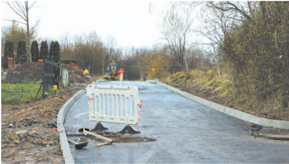
Fragment wyremontowanego odcinka ul. Kenara
