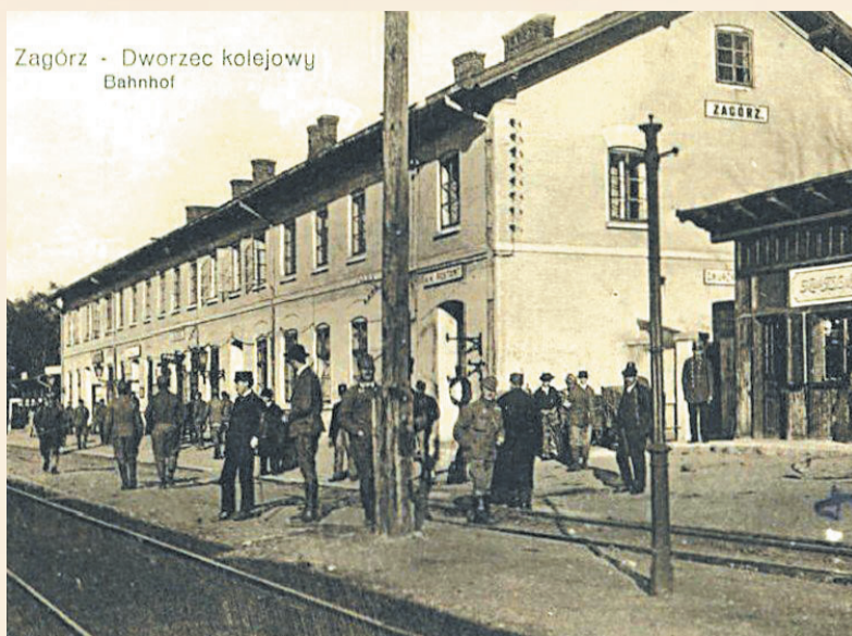
Zagórz. Dworzec kolejowy
