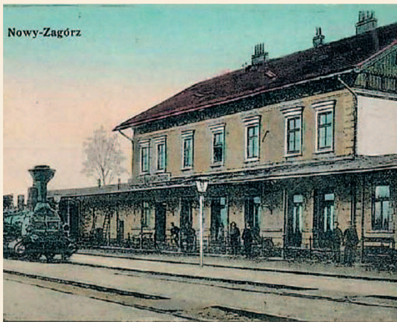
Stacja kolejowa w Zagórz
