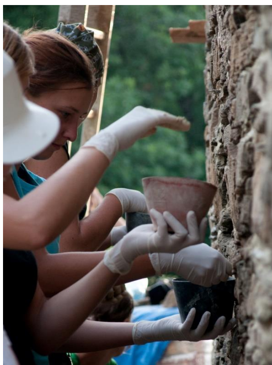
Konserwacja murów, 2012 r. Źródło: ze zbiorów Witolda Grzesika i Marka Kornickiego.
