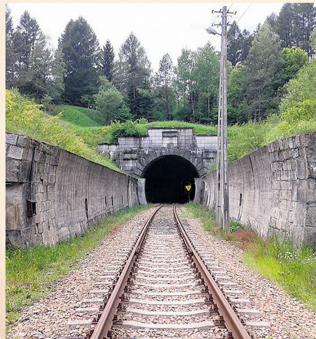
Tunel w Łupkowie
