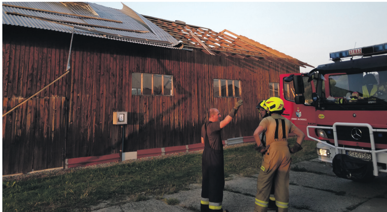
Uszkodzony budynek na Dąbrówce
